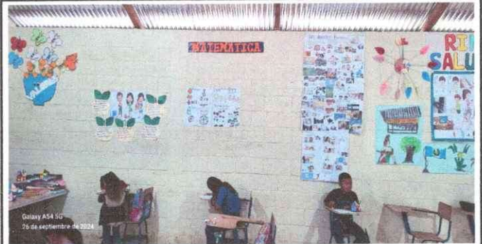
Foto 2: En estas dos aulas se estara instalando las 4 ventanas.
